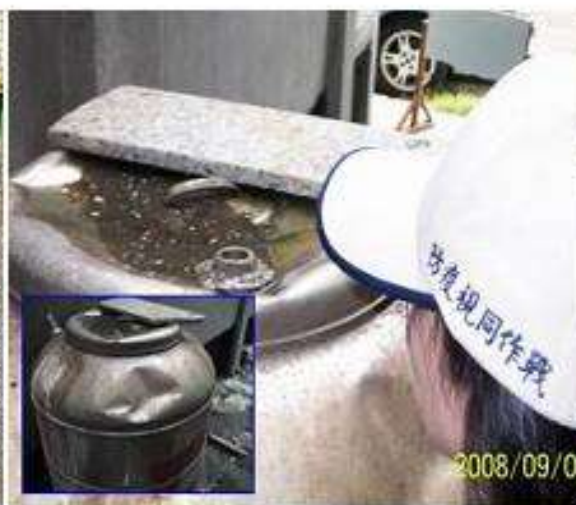
儲水桶鐵蓋凹陷處
