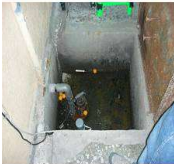
地下室集水槽
