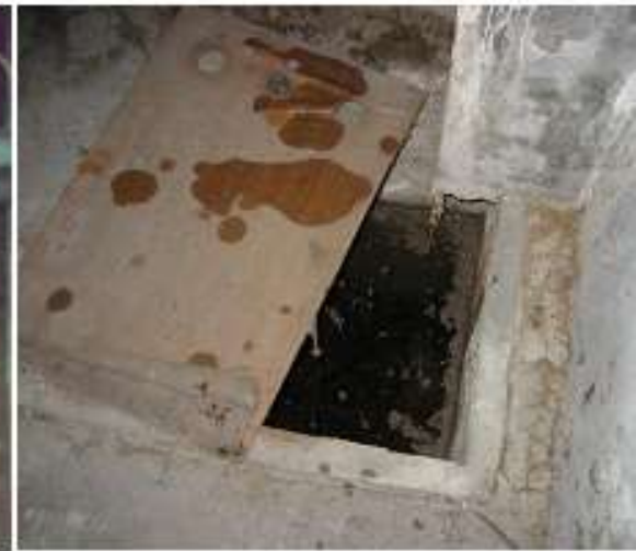
地下室污水池
